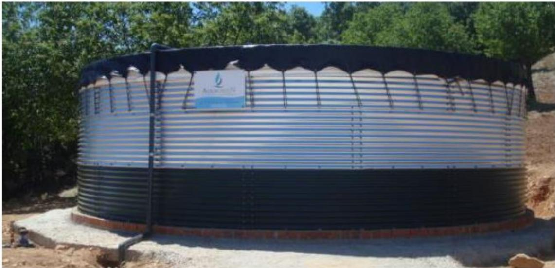
El depósito tendrá una base de hormigón sobre la que se apoya el resto de la estructura. Tendrá una altura de 2 m, por lo que la base será de 25 m<sup>2</sup> libres interior (unos 5,70 m de diámetro).
